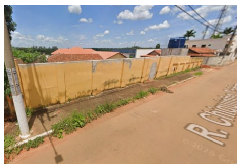
RUA CHIQUINHO CAIEIRO 9º TRECHO - REF.: ESCOLA ESTADUAL
