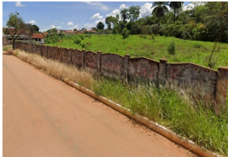
RUA CHIQUINHO CAIEIRO 4º TRECHO - REF.: ANDRE POSTO
