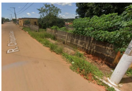
RUA CHIQUINHO CAIEIRO 8º TRECHO - REF.: VALDECI
