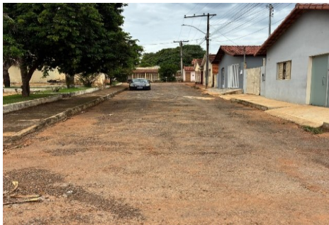
BECO SEM DENOMINAÇÃO COORDENADAS: 19°16'19.26"S 45°33'11.22"O
