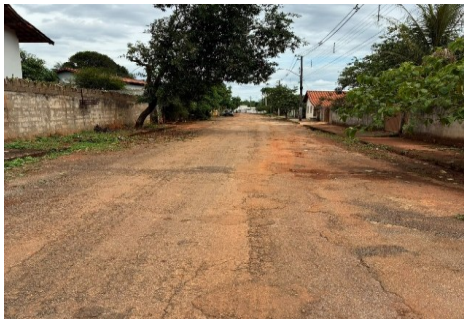
RUA MANOEL DA COSTA COORDENADAS: 19°16'23.19"S 45°33'11.25"O
