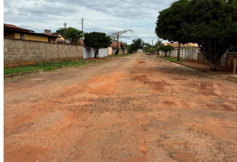
RUA MANOEL DA COSTA COORDENADAS: 19°16'23.19"S 45°33'11.25"O
