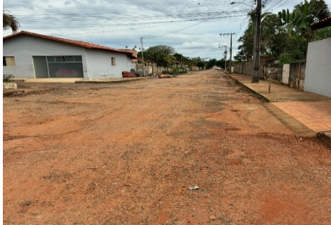
RUA MANOEL DA COSTA COORDENADAS: 19°16'23.19"S 45°33'11.25"O
