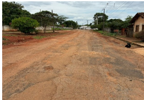
RUA MANOEL DA COSTA COORDENADAS: 19°16'23.19"S 45°33'11.25"O
